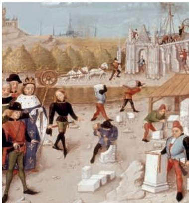
menuisiers construisent les poutres de la charpente ainsi que les machines qui permettent de lever et tirer les blocs de pierre. Interviennent aussi les couvreurs, les sculpteurs, les verriers qui fabriquent les vitraux, les forgerons qui produisent les pitons joignant les blocs de pierre ou les baguettes en plomb tenant les vitraux.
